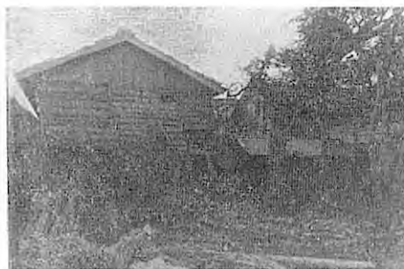
第2室戸台風 阿部一栄宅の作業場
