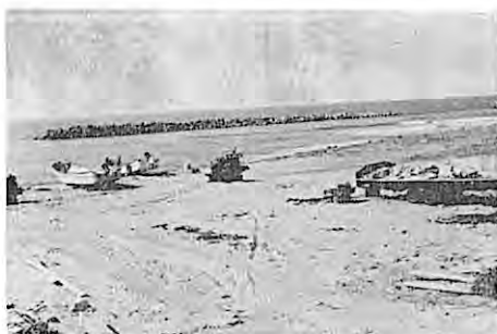
漁港を中心とした上大崎離岸堤
